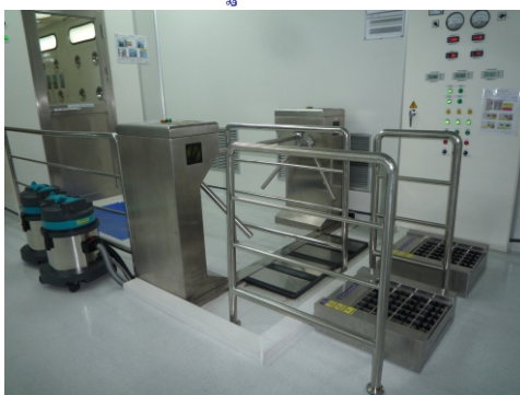
ติดตั้ง CB Vneo-CleanUder พร้อมออฟชั่นเครื่องดูดฝุ่น
